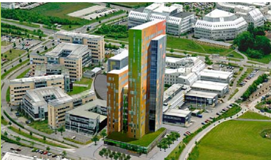
Ideon Gateway i Lund gav under inledningen av innevarande år uppdraget åt Skånska Energi att ansvara för en utsläppsfri geoenergianläggning för sitt värme- och kylbehov.
